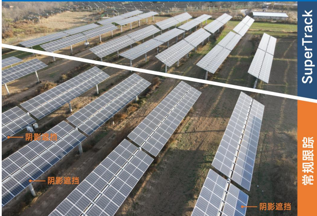
图 21: 逆跟踪阶段常规跟踪阵列与 SuperTrack 智合阵列遮挡情况实拍图
